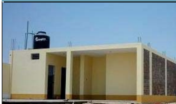
Infraestructura concluida de los servicios higiénicos para varones, damas y de docentes, perteneciente a la Institución Educativa N° 22628 de Condorillo Alto.
