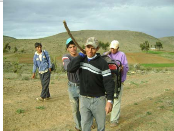
Comunidad de Utapalca, participando en el acarreo de materiales para la construcción de la obra.
