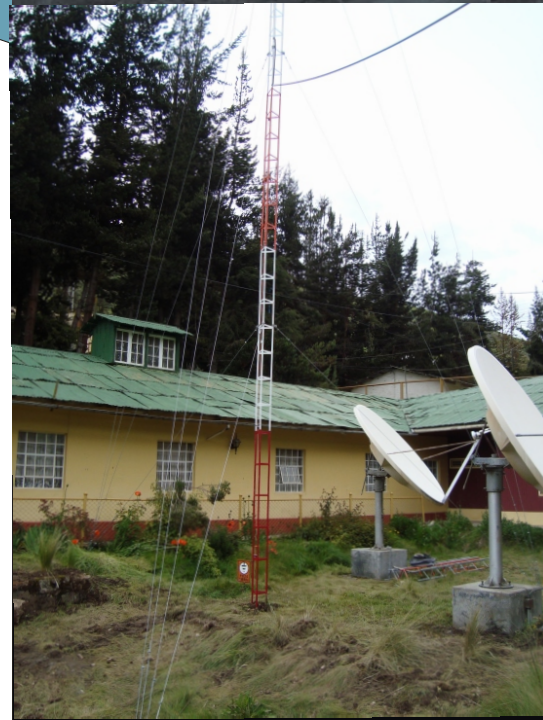
Se implementó dos parabólicas VSAT, y dos torres de 21 metros con antenas omnidireccionales.
