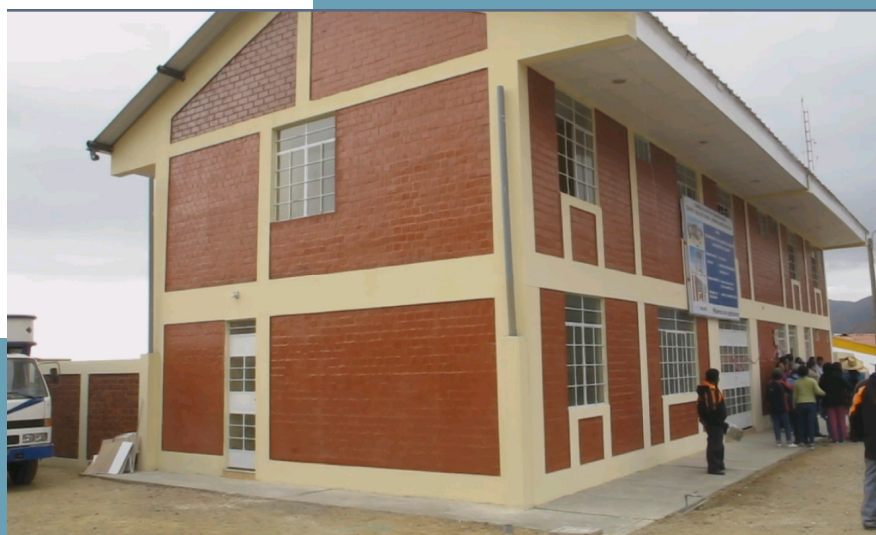
Edward Medina, Gerente Técnico y de Proyectos de Cerro Lindo, junto a Alfredo Peña, alcalde distrital de Chavín y el equipo de RRCC Cerro Lindo, luego de la inauguración.
