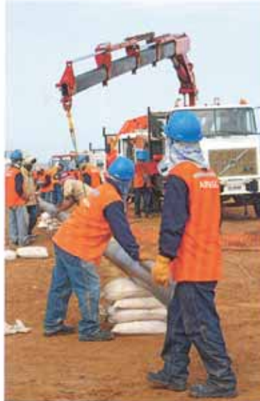
Tuberías de agua desalinizada se extienden a lo largo de 42 kilómetros para llegar a tanques de 3,800 m 3 .
