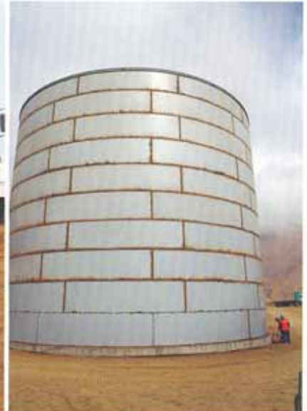
Tuberías de agua desalinizada se extienden a lo largo de 42 kilómetros para llegar a tanques de 3,800 m 3 .
