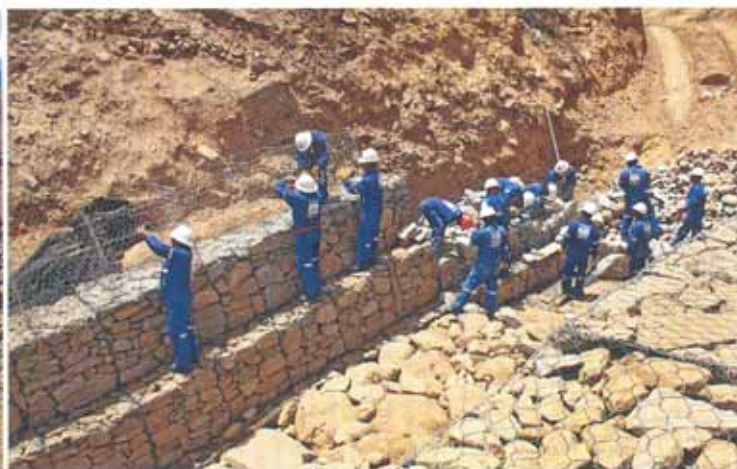
Pobladores de Chavín se han convertido en expertos construyendo gaviones.
